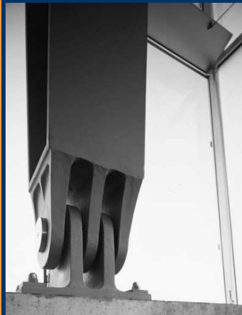
Podparcie przegubowe słupa stalowego [6.2]
