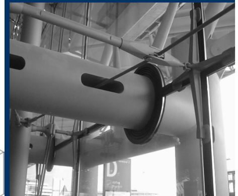
Przebiecie przez szklaną fasadę Cologne Airport [6.2]
