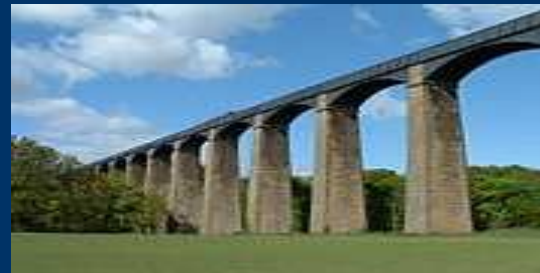
Akwedukt Pontcysyllte w północnej Walii [6.5] → Żeliwne przęsła
