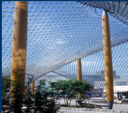
Homebase, London. Centralny maszt ze wspornikiem do napięcia lin-ciągów arch. Nicholas Grimshaw & Partners [6.2]
