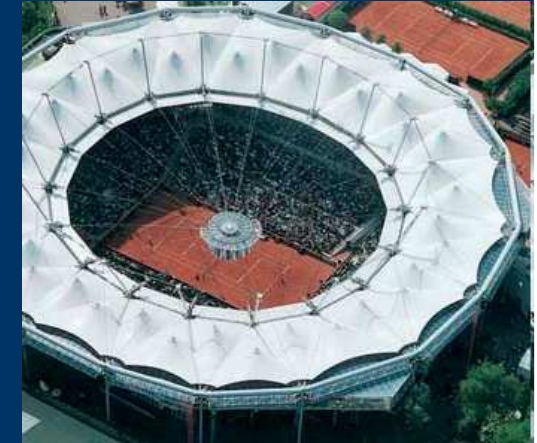
Konstrukcje ciągnowo-linowe w grupie, wyk. Pfeifer [6.5]
